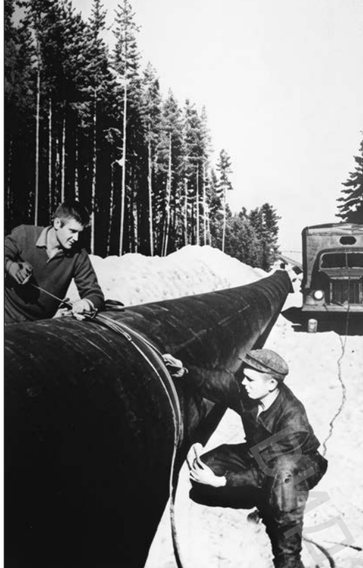
Будівництво газопроводу «Шебелинка—Острог». 1960 р.
