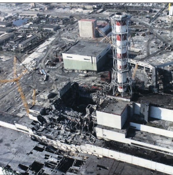
Зруйнований 4-й енергоблок Чорнобильської АЕС унаслідок аварії. 1986 р.
